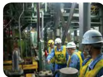
環境重点設備点検
