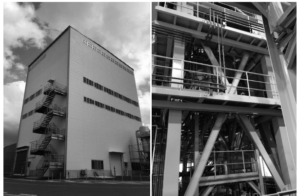
図1. 新ガス噴霧工場.
